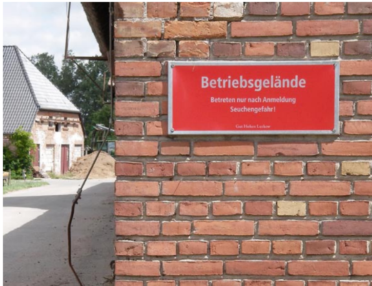
Anwendungsbeispiele des Wegleitsystems in Hohen Luckow, Trägermaterial (Eisen verzinkt) aus der Hofschlosserei, Schrift ausgestanzt (Metall durchscheinend), 3 Farben – 3 Wahrnehmungsstufen: Rot = Zugang verboten, Blau = Zugang erwünscht, Anthrazit = Zugang möglich und allgemeine Informationen
